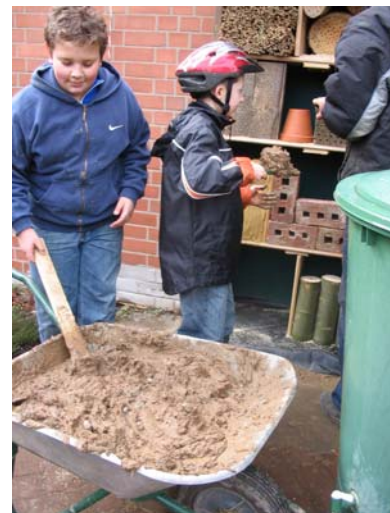
Fachmännisch wurde der Lehm angerührt...
